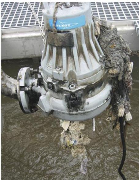
Eine durch Faserreste und Fremdkörper verstopfte Schmutzwasser-Pumpe.
